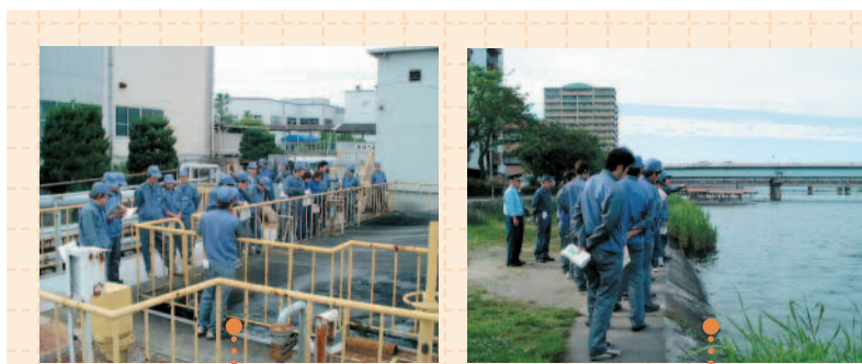
排水の処理設備
